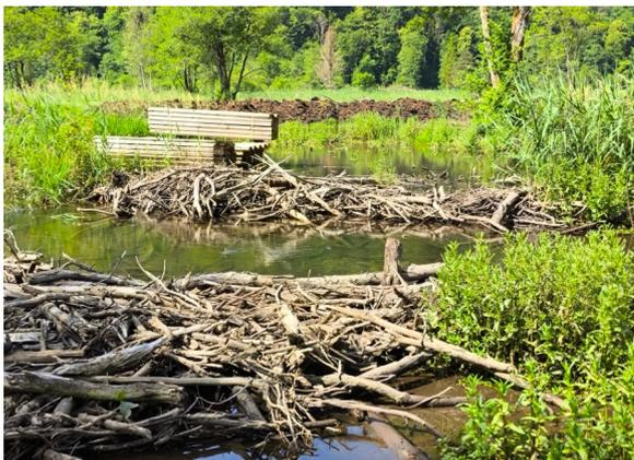
Au niveau d'un point de jonction entre le méandre de l'ancien lit et le lit actuel, des madriers restent encore à poser (bois empilés en arrière plan ) qui vont permettre de réalimenter l'ancien lit du cours d'eau par tronçons successifs.
